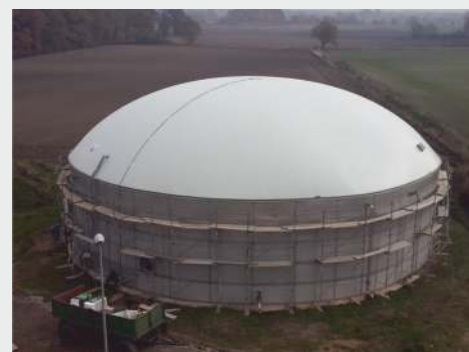
Zbiornik biogazu w Sieńsku 26 m średnicy
