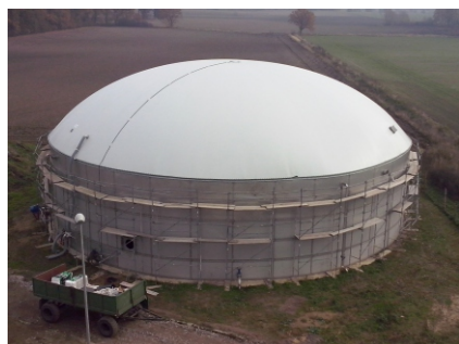
Zbiornik 2-membranowy dach 1270 m 3 Biogazownia Sieńsk
