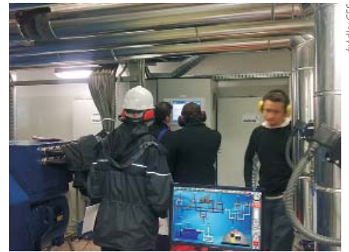
▲ Ilustracja 2: Sterowanie układem kogeneracyjnym oraz jego wizualizacja w systemie Scada
