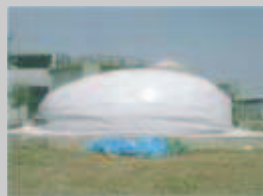
faza 2: montaż dwóch membran komory powietrznej na komorze gazowej
