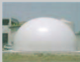
faza 3: instalacja zaworów i wyposażenia oraz testy końcowe
