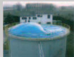
faza 2: montaż dwóch membran komory powietrznej na komorze gazowej
